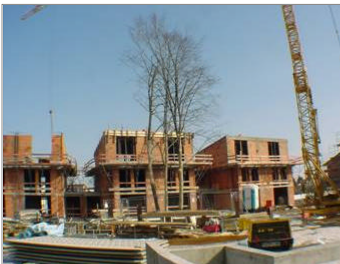
Abb. 7 Baumschutz während der Bauzeit
