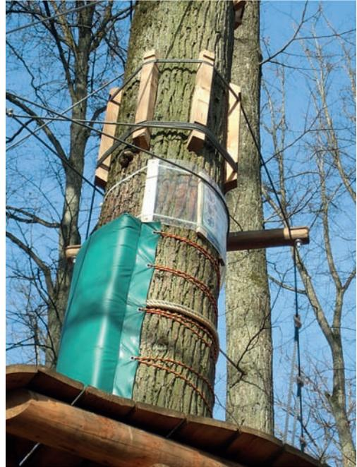
**Abbildung 4: Druck verteilender Kranz aus Holzkeilen, Aufprall- und Stammschutz**
