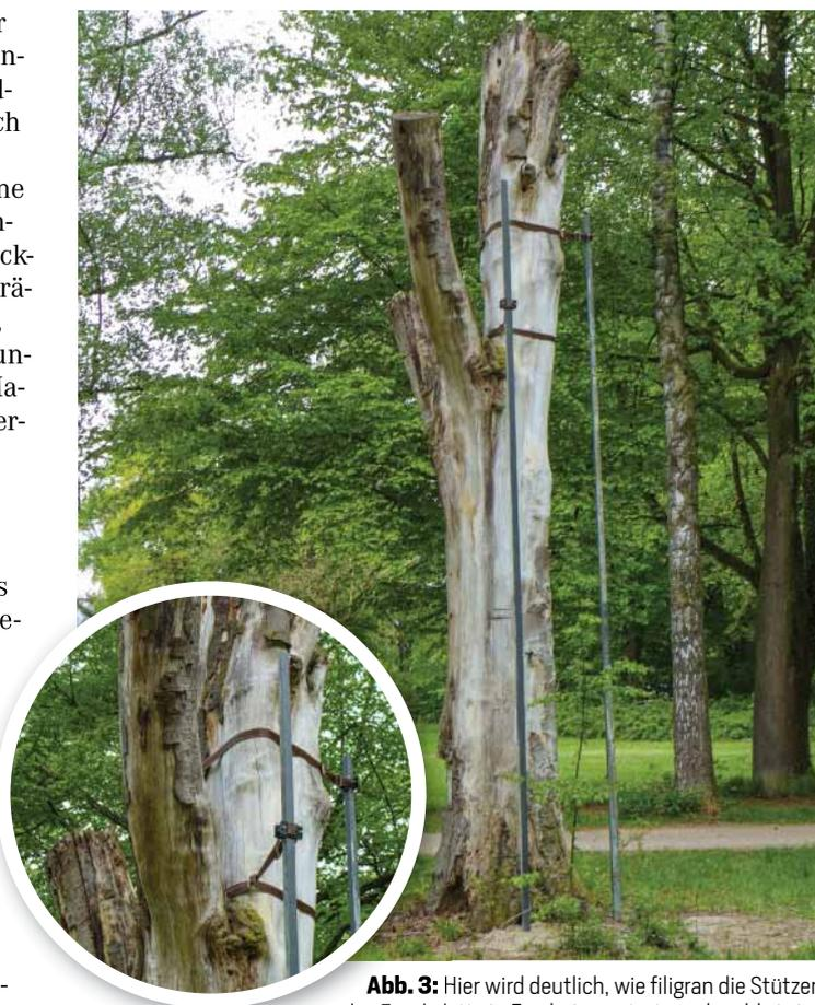
**Abb. 3:** Hier wird deutlich, wie filigran die Stützen des Exoskeletts in Erscheinung treten, obwohl sie in der Lage sind, die rund 3 t Eigengewicht des Baums zu stabilisieren. Mit den Gurten werden die Kräfte des Baums bei Sturmbelastung auf das Exoskelett übertragen.
