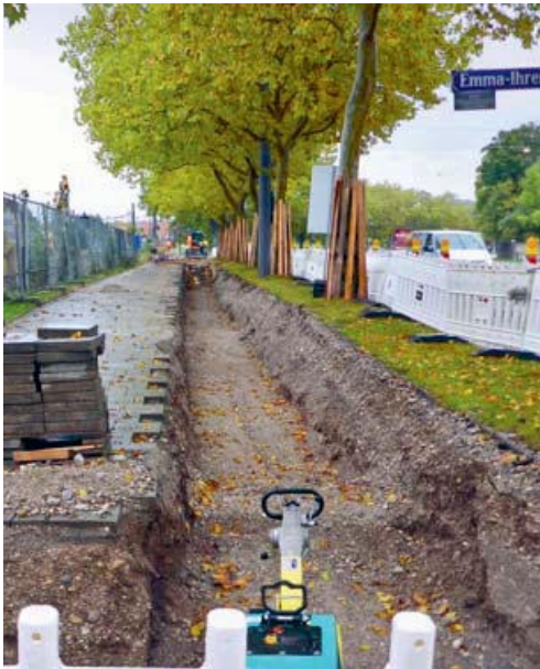
Abbildung 3: Straßenparallele Abgrabung: Zugversuche müssen senkrecht zum Grabenverlauf durchgeführt werden, auch wenn dies ungleich aufwendiger ist als parallel zur Grabung (Foto: M. ADAMEK, München).
